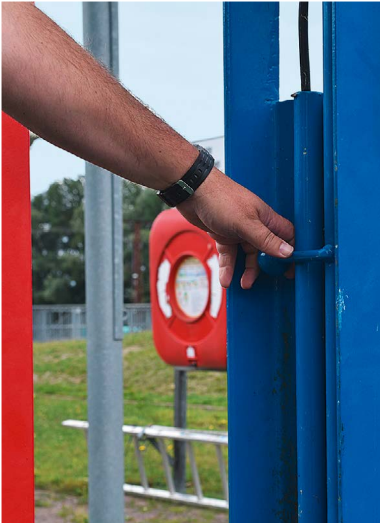
Durch Betätigung des blauen Hebels wird der Schleusenvorgang angemeldet
