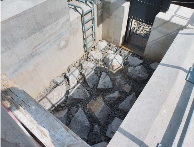
Einzelnes Schlitzpassbecken der FAA Malliß
