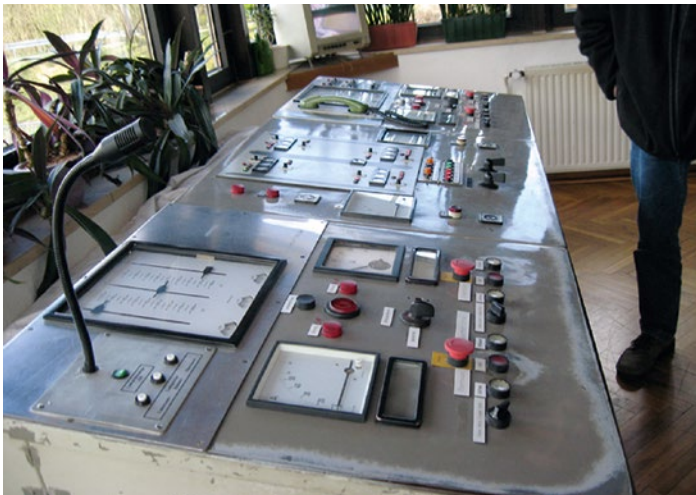
Altes Bedienpult mit Relaischnik
