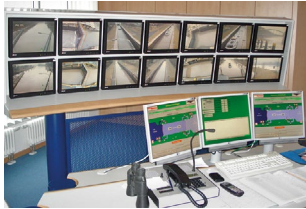
Arbeitsplatz in der Leitzentrale Minden – seit 2003 in Betrieb
