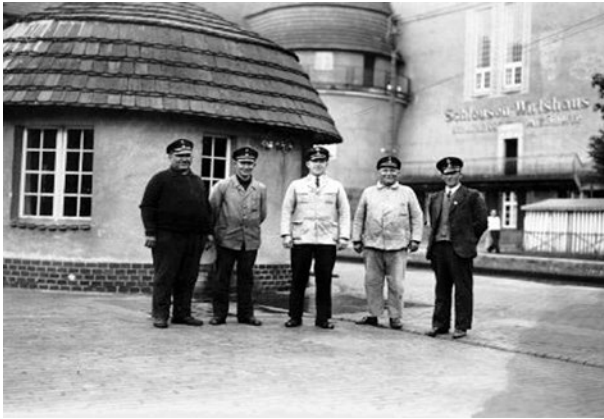
Schleusenbesatzung, erste Hälfte des 20. Jahrhunderts
