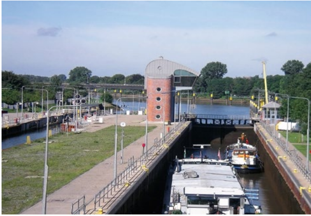
Zentraler Bedienstand der Schleuse Bremen
