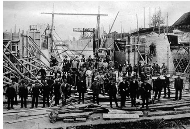
Bau der Schleppzugschleuse Altenrheine (Dortmund-Ems-Kanal) um 1914
