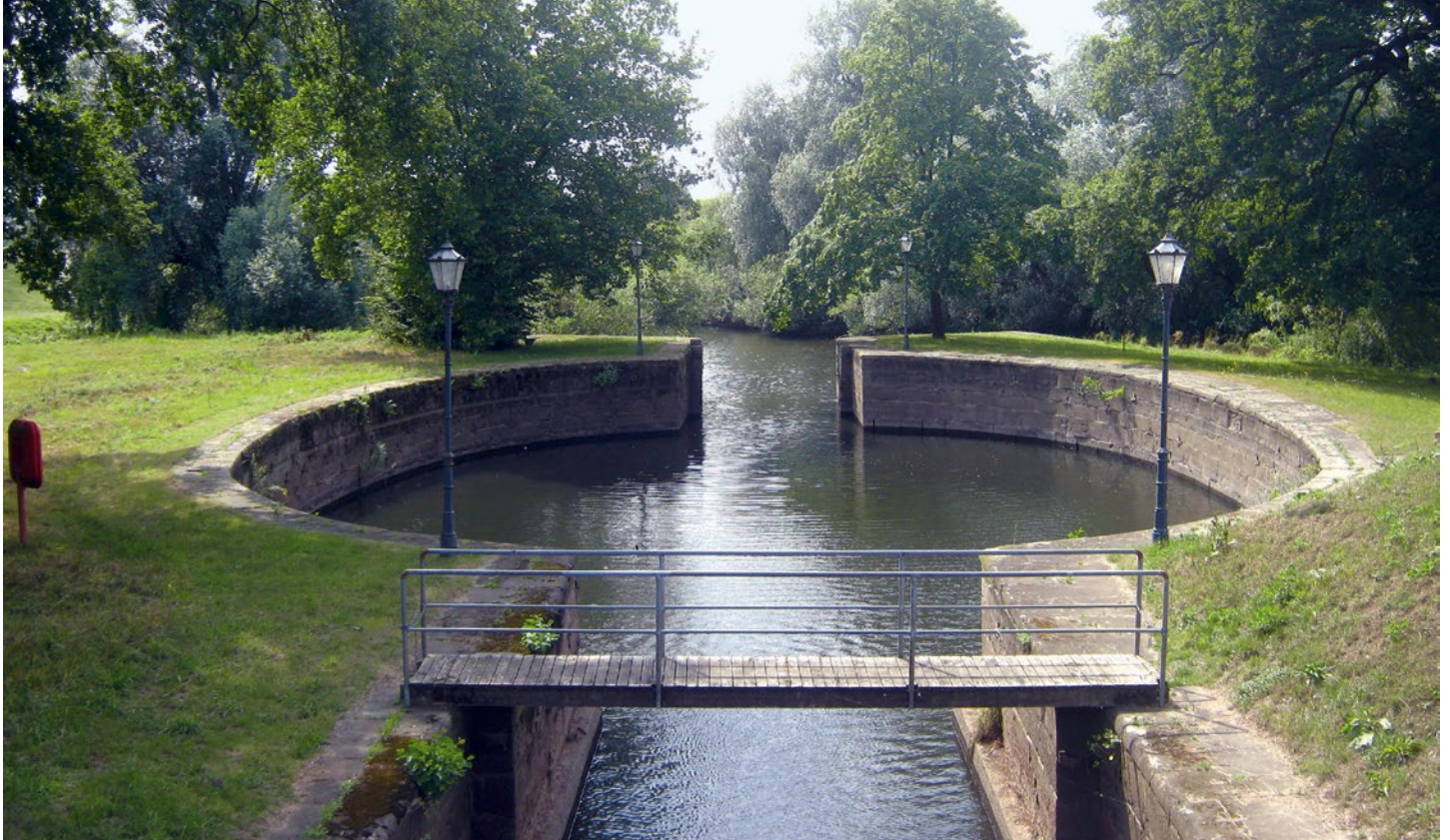
Palmschleuse in Lauenburg
