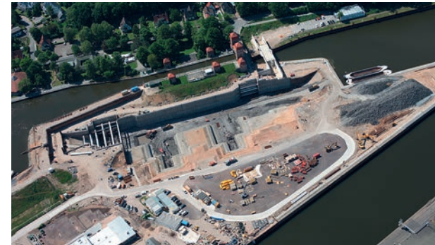
Schleusenanlage mit neuer Schleuse
