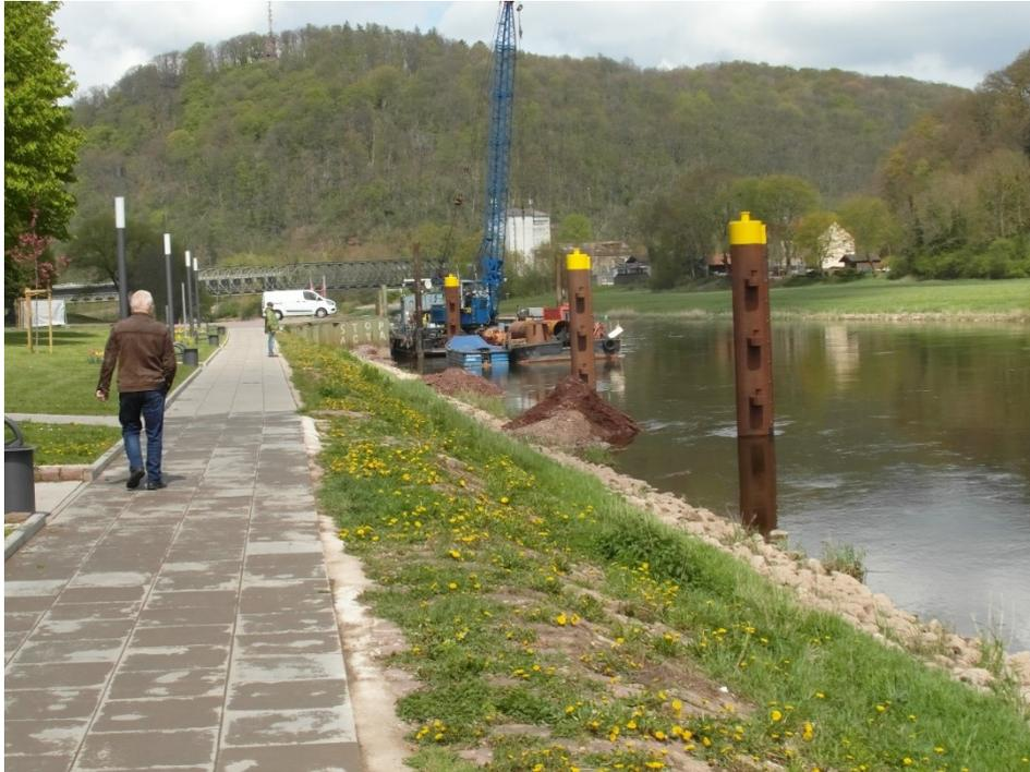
Dalbengestützter Schiffs- und Bootliegeplatz Bodenwerder am linken Ufer der Weser- km 111,305 bis 111,365.
